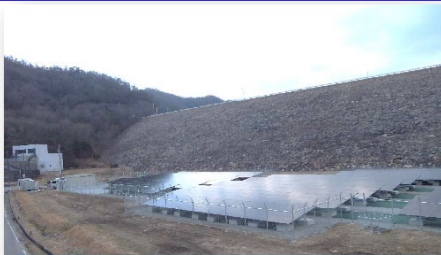
糺屋ダム堤体下の広場を利用した太陽光発電施設
