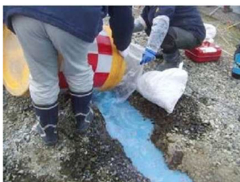
写真-d 石灰水注入状況（着色料混入）
