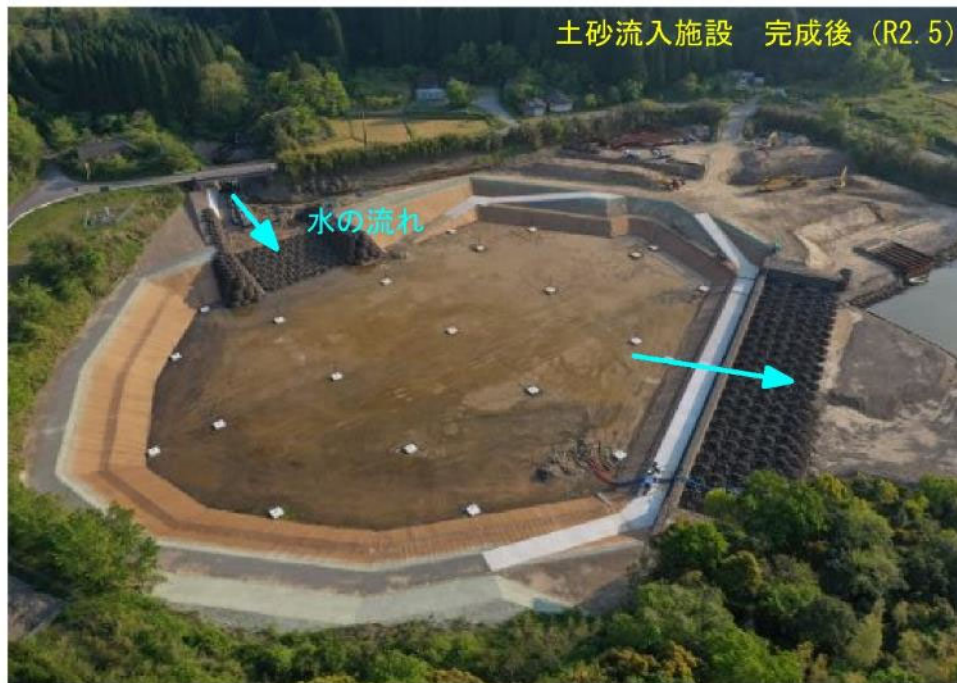
沈砂池完成状況写真
