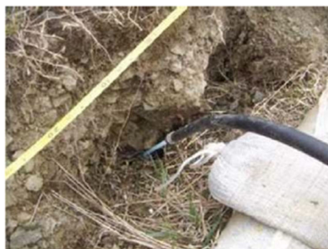
写真-e 石灰水注入状況（ポンプ注入）
