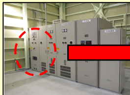
〔回転速度制御（インバータ制御）設備の設置〕
