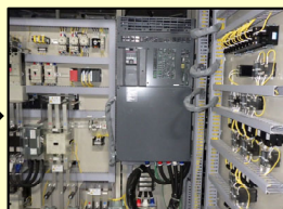
〔回転速度制御（インバータ制御）設備の設置〕
