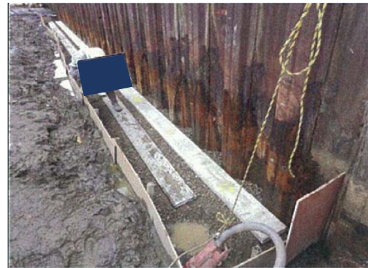
写真 5. 2-13 均しコンクリート工（例）
