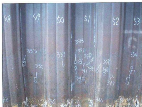
写真 1.2-1 孔食及び開孔の状況(例)
