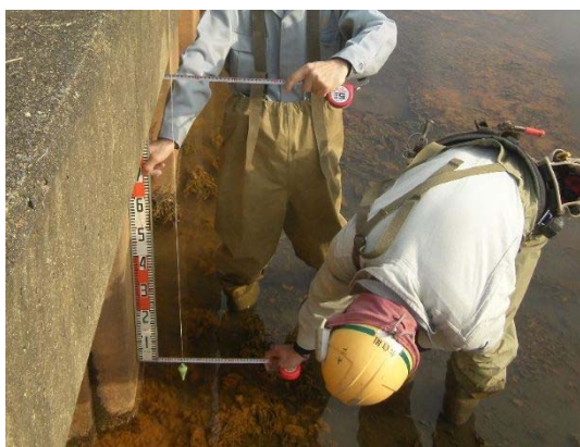
写真 1.2-5 下げ振りによる測定状況（例）
