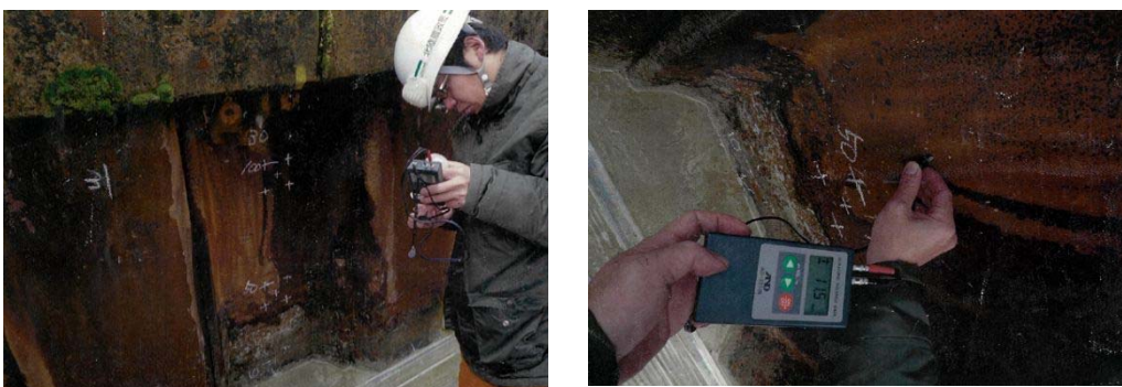
写真 1.2-3 超音波厚さ計による測定状況（例）
