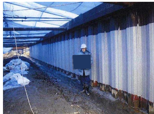
写真 5.2-2 ビニールシート養生設置（例）
