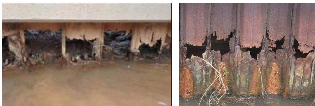
写真 2.2-1 断面欠損（例）
