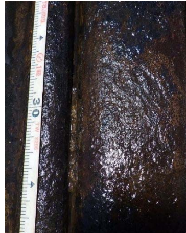
写真 5.1-10 素地調整後 (高圧洗浄工法)
