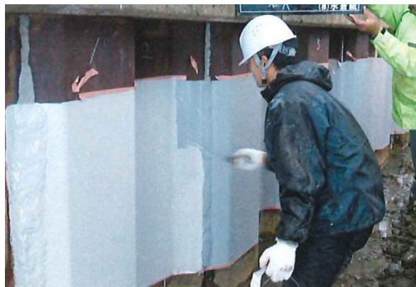
写真 5.2-9 上塗り材塗布（例）
