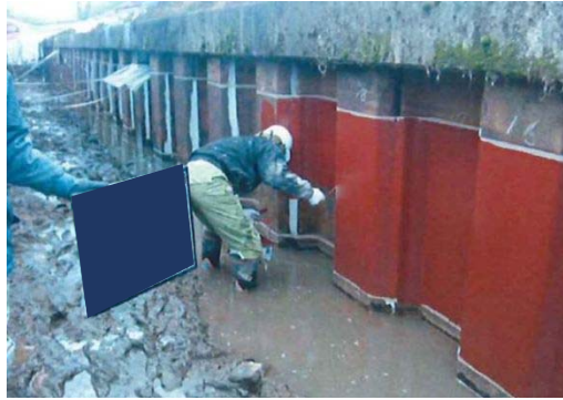
写真 5.2-5 プライマー工（例）
