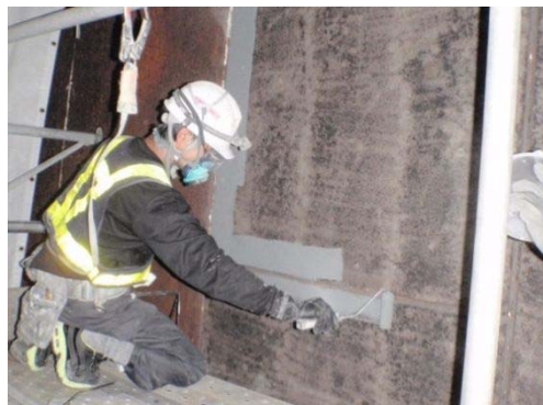
写真 5.2-4 防食下地材の塗布（例）
