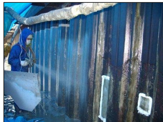
写真 3.2-2 有機系被覆工法 （吹付け型）施工状況
