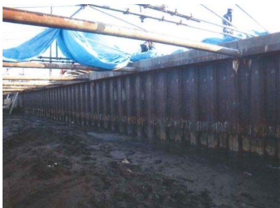
写真 5. 1-5 試験状況(素地調整完了) (例)
