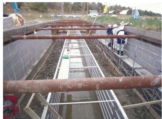
写真 5.1-1 鋼製組立式仮設水路の設置（例）
