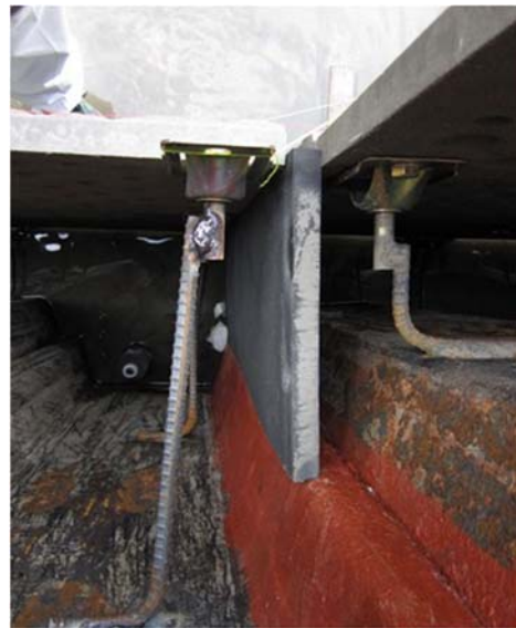
写真 5. 2-17 伸縮目地の設置状況
