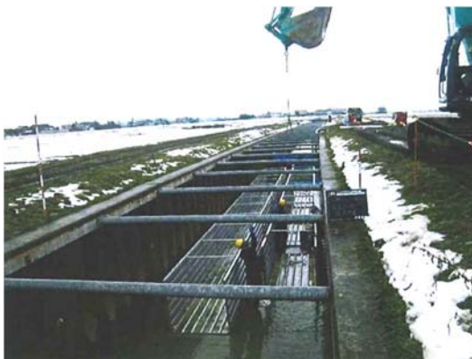
写真 5.1-1 鋼製組立式仮設水路の設置（例）
