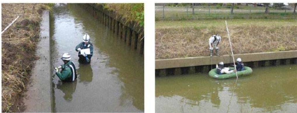
写真 1.2-2 板厚測定状況（例）
