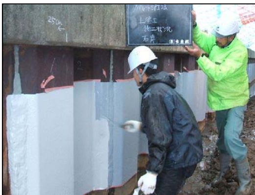
写真 3.2-1 有機系被覆工法 （塗付け型）施工状況
