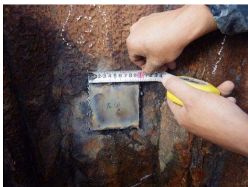
写真 5.1-11 当て板溶接による 開孔処理（例）
