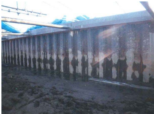
写真 5. 1-3 現場試験施工前 (例)
