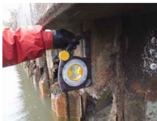
写真 1.2-6 傾斜計による測定状況（例）
