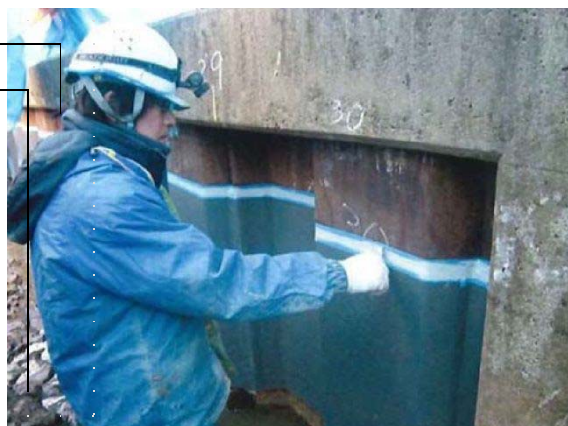
写真 5.2-10 端部のシーリングによる保護（例）
