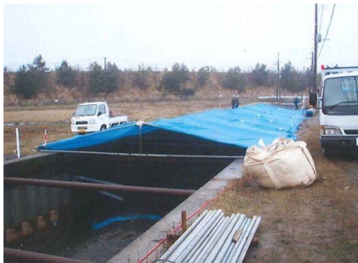
写真 5.2-1 ビニールシート養生設置（例）
