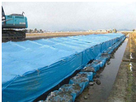
写真 5.1-2 養生工の設置（例）
