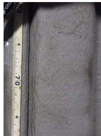
写真 5.1-8 素地調整後 (オーブンブラスト)
