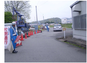
安全施設・交通誘導員の配置
