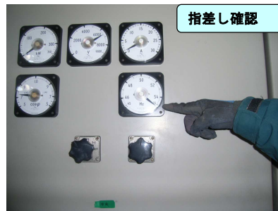
例；高圧盤概略診断調査状況
