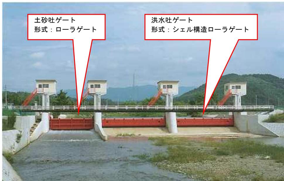
写真-6.1.1 頭首工の土砂吐及び洪水吐ゲートの設置例
