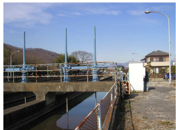
写真-6.1.3 沈砂池の制水ゲートの設置例
