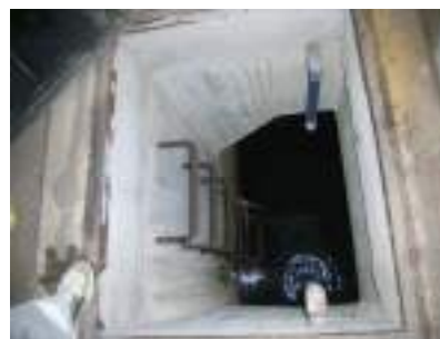
既設タラップ活用
