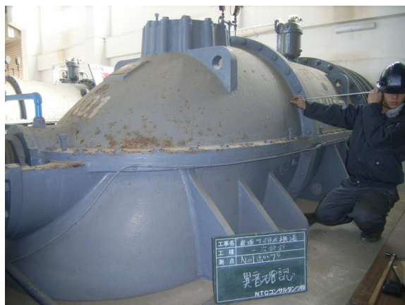
(1)本体（全体） 異常音なし（S-4）（劣化影響度はA）
