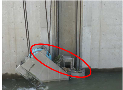
写真-6.2.3 シーブへの塵芥干渉
