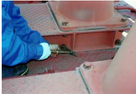
テストハンマーによる打診確認
