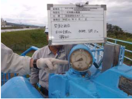
開度計（開閉装置）の動作確認
