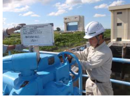
手動ハンドル（開閉装置）の動作確認
