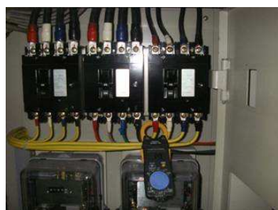
クランプメータによる電流測定
