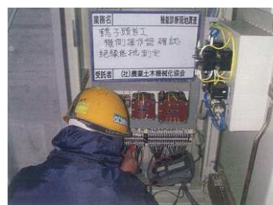
テスターによる電圧測定
