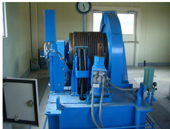
写真-6.1.5 ワイヤロープウィンチ式開閉装置の事例写真
