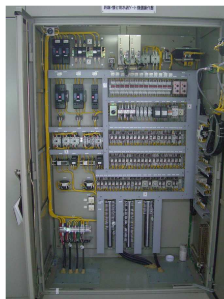
写真-6.1.8 機側操作盤の正面、内部構造事例写真
