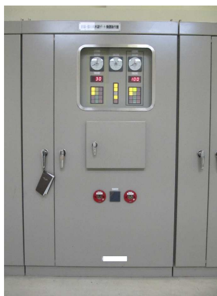
写真-6.1.8 機側操作盤の正面、内部構造事例写真
