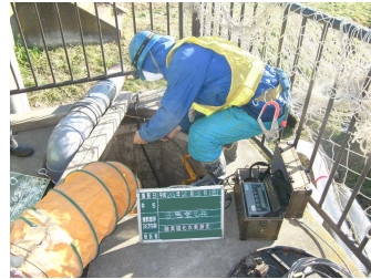
送風機による換気作業
