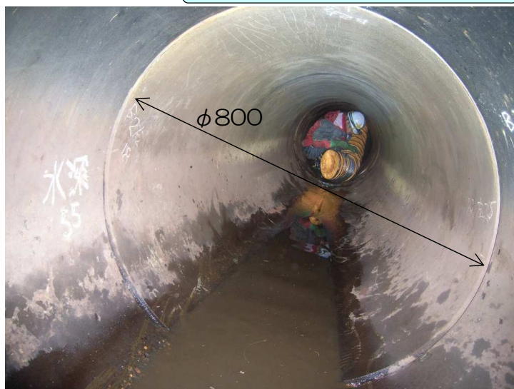
\phi 800 の管内の状況
