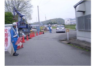
安全施設・交通誘導員の配置
