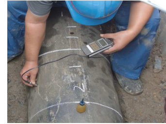
管厚計測（厚み計による）
