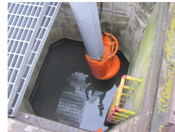
ポンプによる水替え作業
