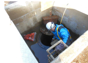
管理用人孔からの進入
