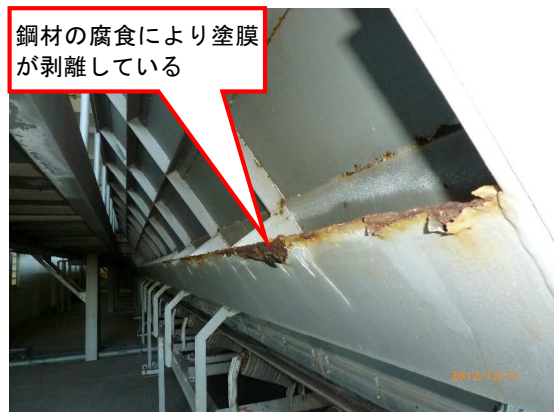
写真-9.1.7 エプロン背面の腐食の例
