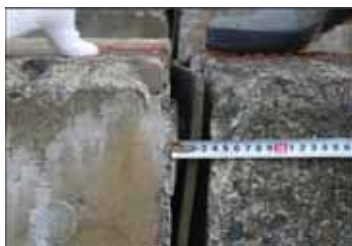
写真 硬化した目地材
