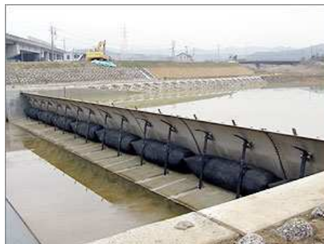
【S R堰の全体写真】
