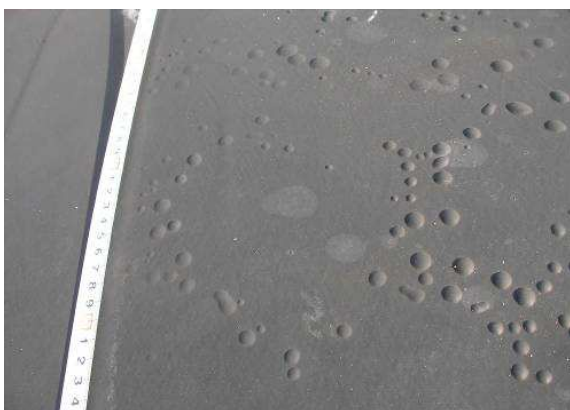
写真-7.1.10 袋体の凸状膨れの例
