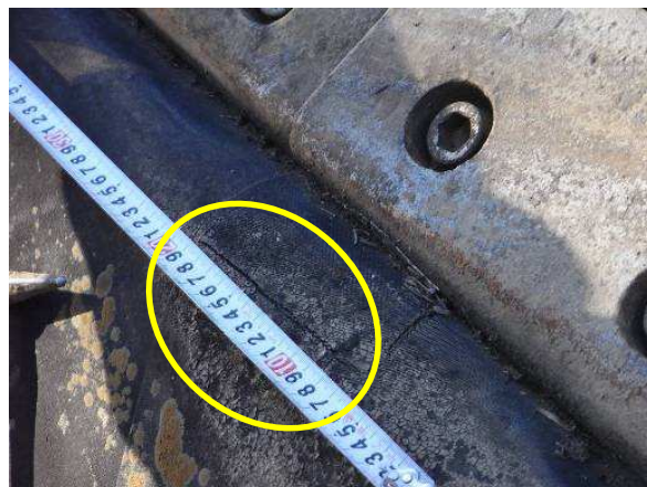
写真-7.1.9 袋体のクラックの例
