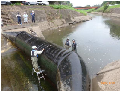
写真-7.2.8 脚立、点検台使用例
