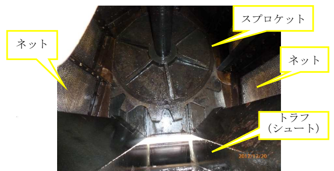
ネット形除塵機内部構造例
