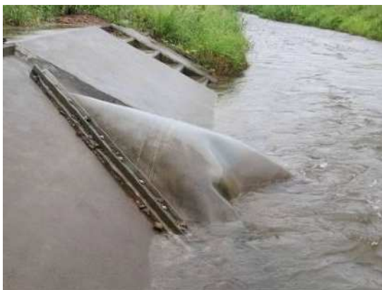
例；空気または水の残留による不完全倒伏
