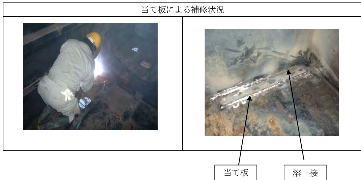
図 5.3.8 扉体補修事例
