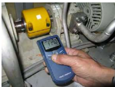
非接触式回転計による電動機回転数測定状況
