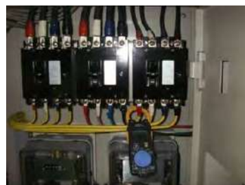
クランプメータによる電流測定
