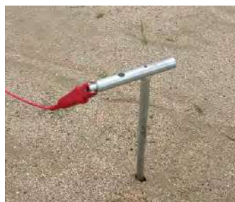
補助接地棒打込み状況
