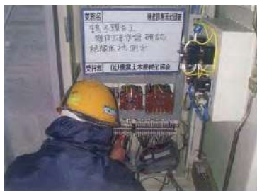
テスターによる電圧測定
