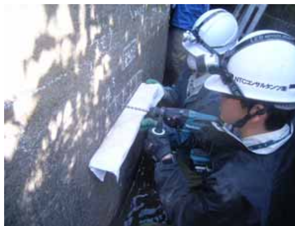
写真-5.2.28 ドリル法による中性化試験
