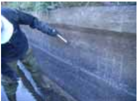
テストハンマーによる 打音調査
