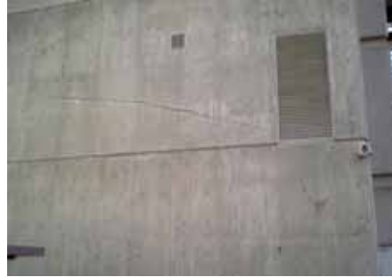
写真-5.2.11 コールドジョイントによるひび割れ
