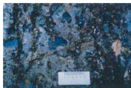
写真-5.2.25 粗骨材の露出
