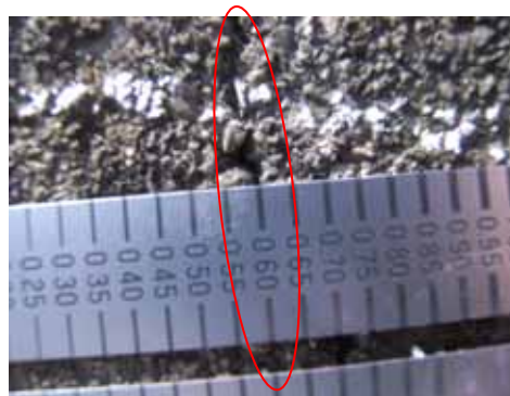
写-5.2.7 ひび割れ幅計測
