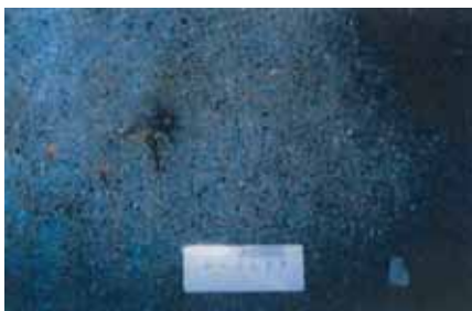
写真-5.2.24 細骨材の露出
