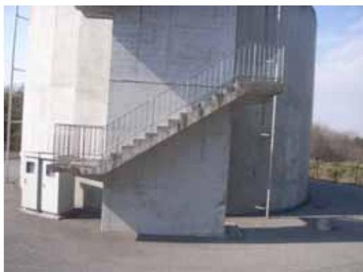
写真-3.2.81 昇降施設（RC構造）
