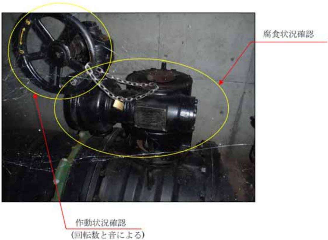
図-3.2.50 バルブ調査の内容（制水弁）
