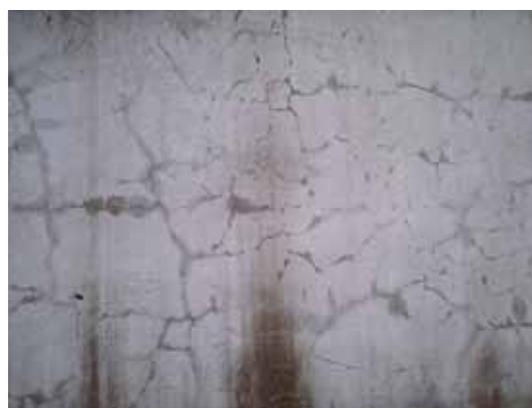
写真-3. 2. 69 モルタル層のひび割れ
