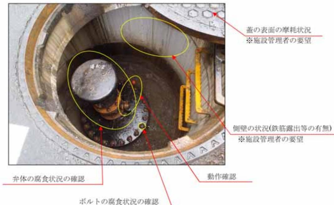
図-3.2.48 バルブ調査の内容（空気弁）
