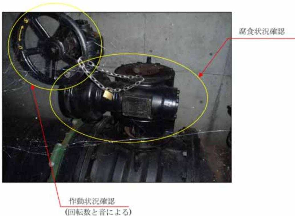
図-3.2.47 バルブ調査の内容（バタフライ弁）
