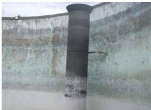
写真-3.2.78 内面塗装の劣化
