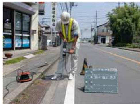
図-3.2.54 漏水確認調査概要図
