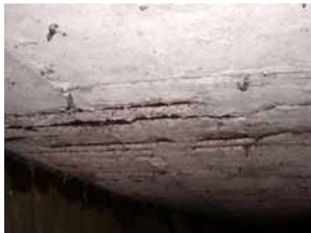
写真-3.2.66 中性化（ボックスカルバート；鉄筋に沿ったひび割れ；塩害も同様の形状を示す）
