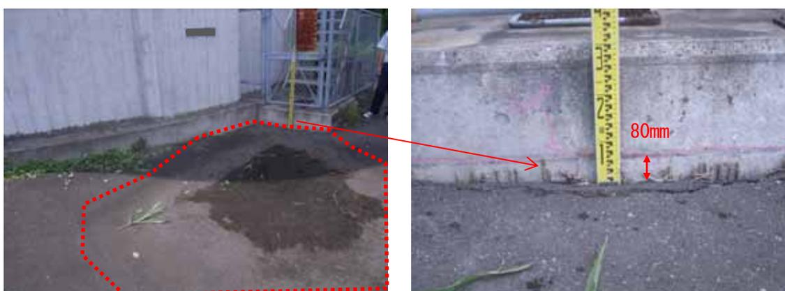
写真-3.2.80 地盤沈下による抜け上がりの例
