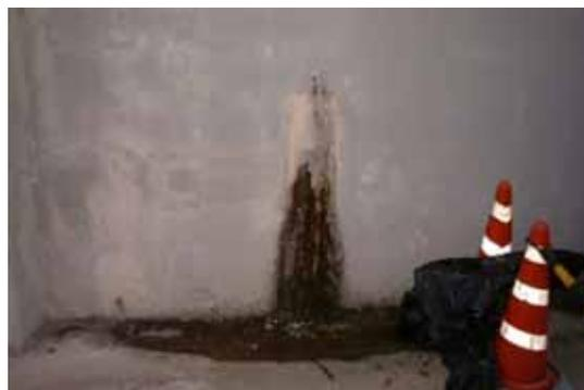
写真-3. 2. 65 PCタンクの温度ひび割れの事例
