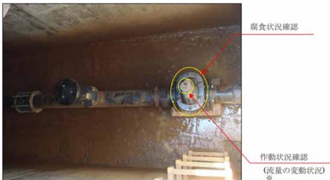
図-3.2.49 バルブ調査の内容（仕切弁）
