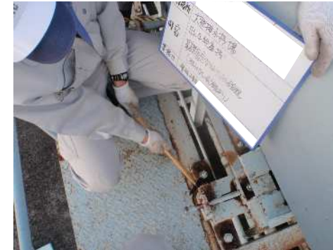
テストハンマーによる打診確認
