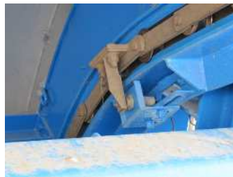
ガイドレールの調査
