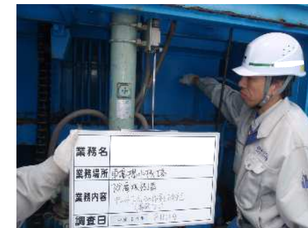
リミットスイッチ（除塵機）の動作確認
