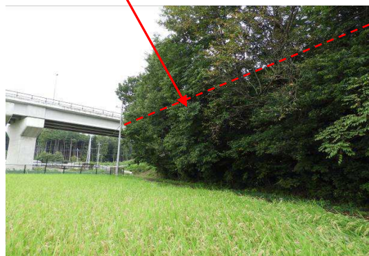
架空線の状況
