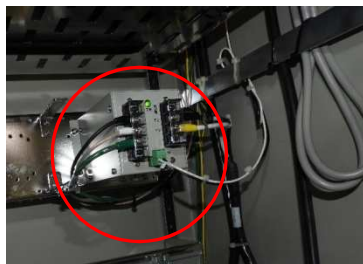
図-11.1.14 TM・TC 子局装置内の避雷器の例
