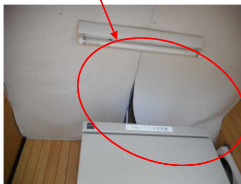
局舎内部の状況
