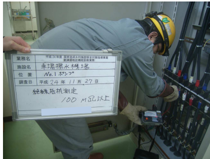
絶縁抵抗測定状況（高圧）
