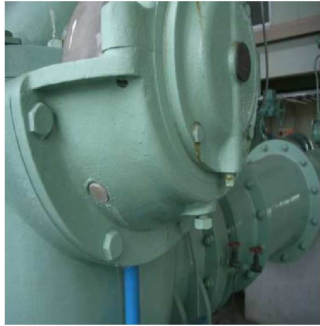
ポンプ軸受部の油漏れ（油がにじんでいる）
