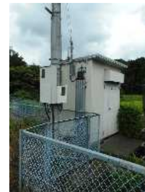
局舎設置環境
