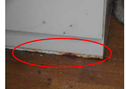
TM・TC子局装置架台の発錆
