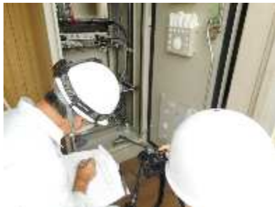
現地踏査の状況
