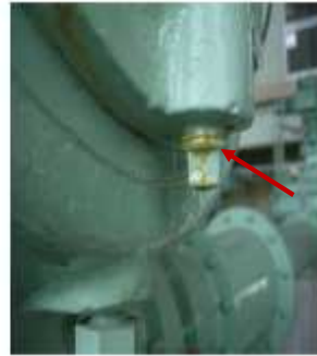
ポンプ軸受部の油漏れ（油がにじんでいる）
