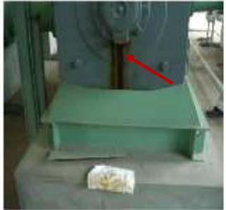
電動機の軸受部の油漏れ（漏れた跡、にじんでいる）
