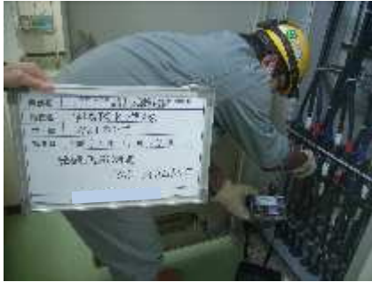
絶縁抵抗測定状況（高圧）
