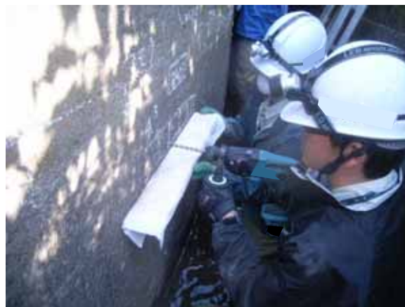
写真-2. 2. 20 ドリル法による中性化試験
