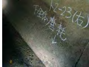
摩耗・骨材露出
