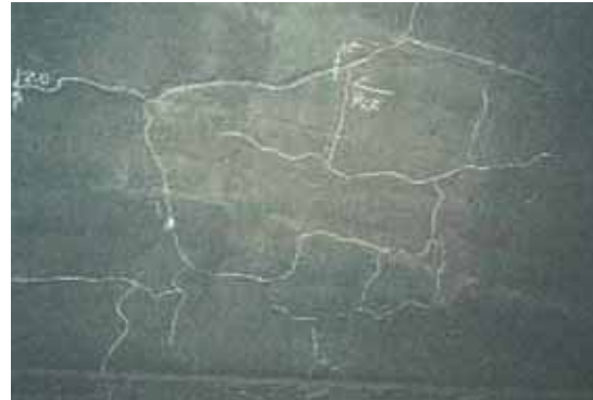
図-2.2.16 乾燥収縮・温度応力ひび割れ発生位置 写真-2.2.5 不規則なひび割れ
