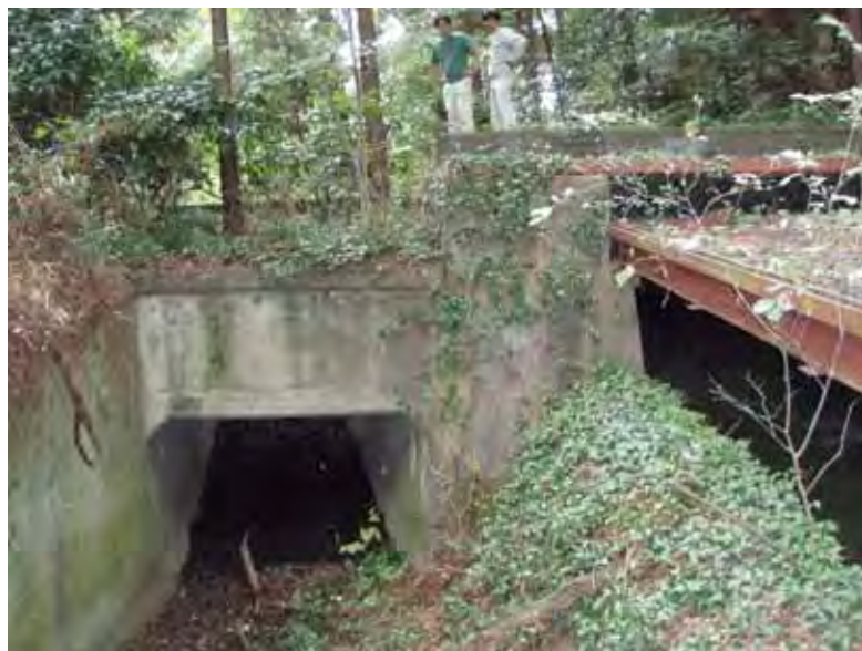
写真-2.2.2 水路トンネル上部地盤から観察
