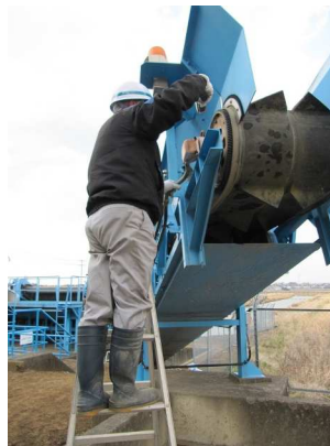
写真-9.2.7 コンベヤ点検状況
