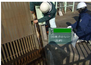
レーキチェーンの伸びの測定状況（左写真）及び測定範囲（右図）
