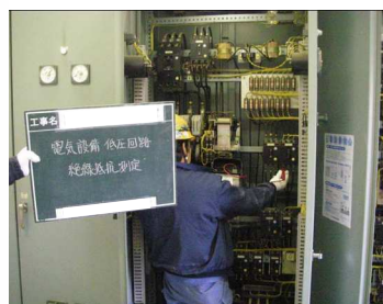
絶縁抵抗測定状況
