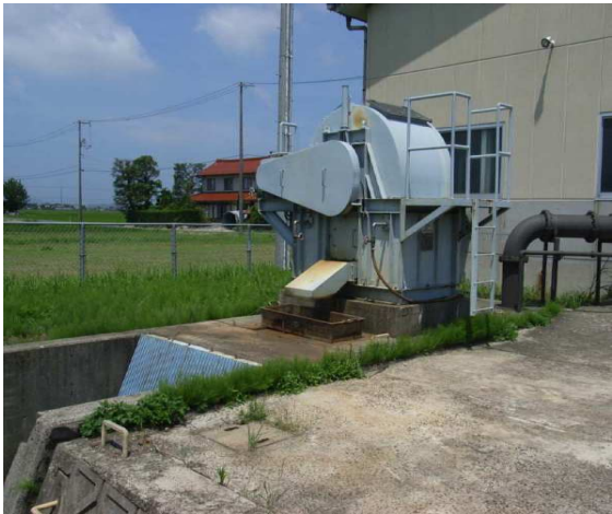
写真-9.1.2 用水機場の除塵機（ネット形）の設置例
