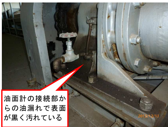
写真-9.1.6 減速機の油漏れの例
