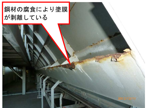
写真-9.1.7 エプロン背面の腐食の例
