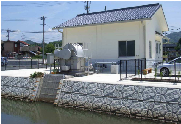
写真-9.1.2 用水機場の除塵機（ネット形）の設置例
