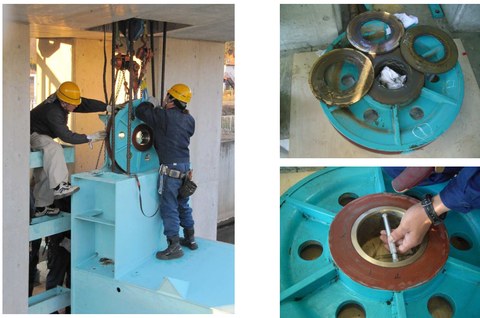
写真-6. 2. 15 ローラゲートシーブの分解計測状況
