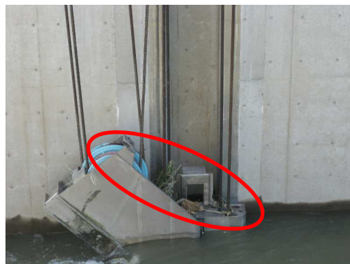
写真-6.2.3 シーブへの塵芥干渉
