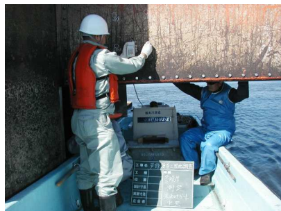
船上からの調査状況
