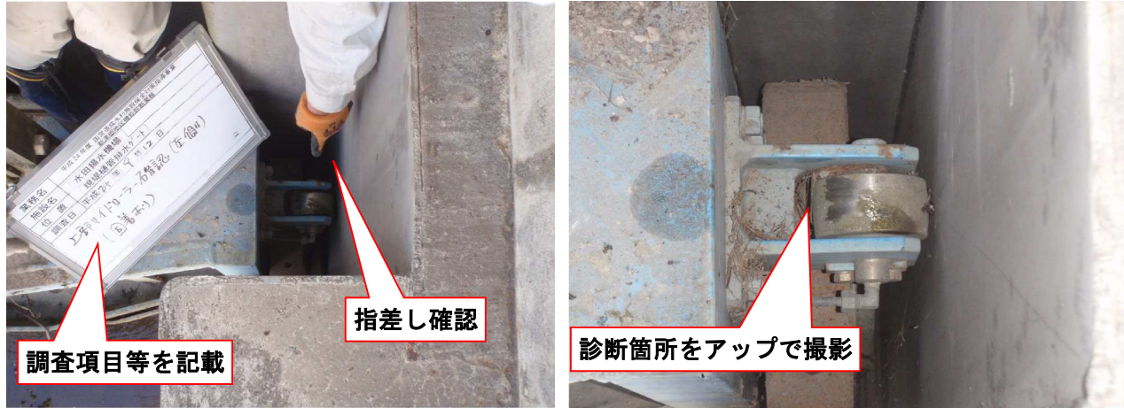
写真-6.2.6 サイドローラー確認例
