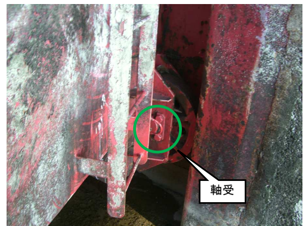
②主ローラの軸受の摩耗量確認等
