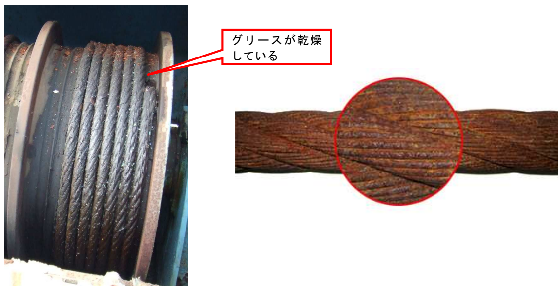
写真-6.1.19 ワイヤロープの給油不足の例（左）及び腐食の例（右）
