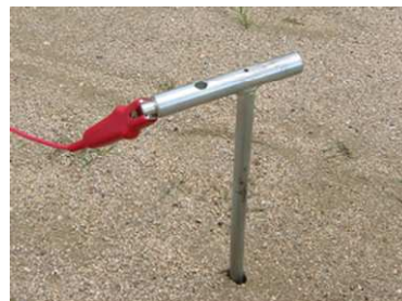
補助接地棒打込み状況
