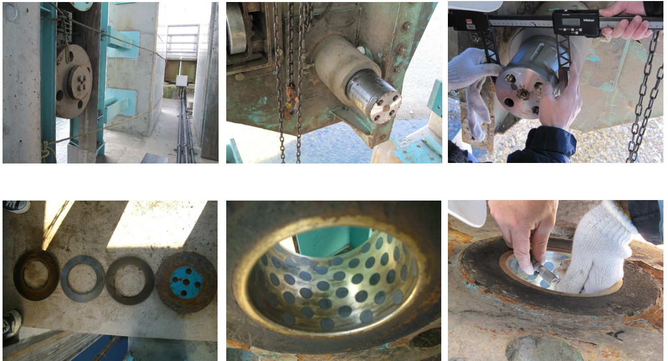
写真-6. 2. 14 ローラゲート主ローラの分解計測状況
