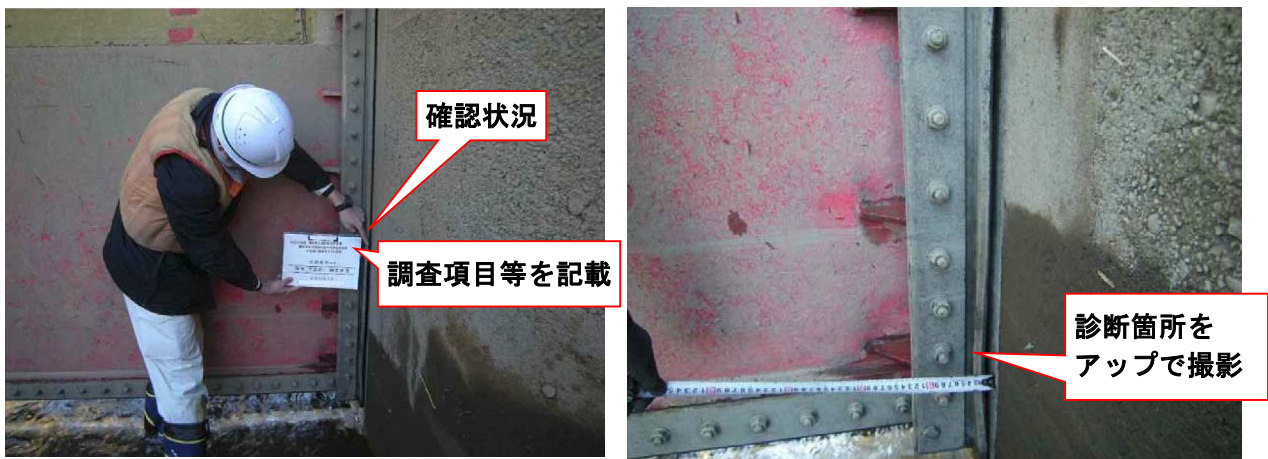
写真-6.2.7 側部水密ゴム確認例
