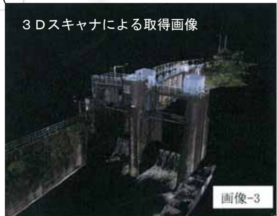
図-4.2.25 門柱の変計量調査結果事例（3Dセンサーによる測定）
