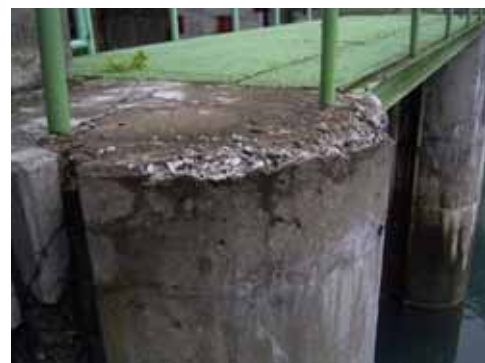
写真-4. 2. 16 凍害とASRの複合劣化（近接すると凍害によるスケーリング・剥離が観察される）
