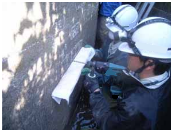
写真-4.2.25 ドリル法による中性化試験
