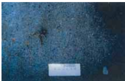
写真-4.2.20 細骨材の露出
