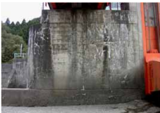
写真-4. 2. 16 凍害とASRの複合劣化（近接すると凍害によるスケーリング・剥離が観察される）
