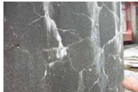
写真-4. 2. 15 ASR（堰柱；ゲルの滲出が見られる）
