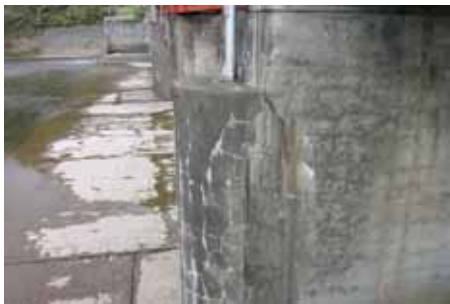
写真-4. 2. 15 ASR（堰柱；ゲルの滲出が見られる）
