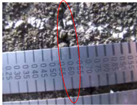
写真-4.2.9 ひび割れ幅計測
