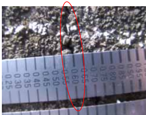
写真-3. 2. 48 ひび割れ幅計測
