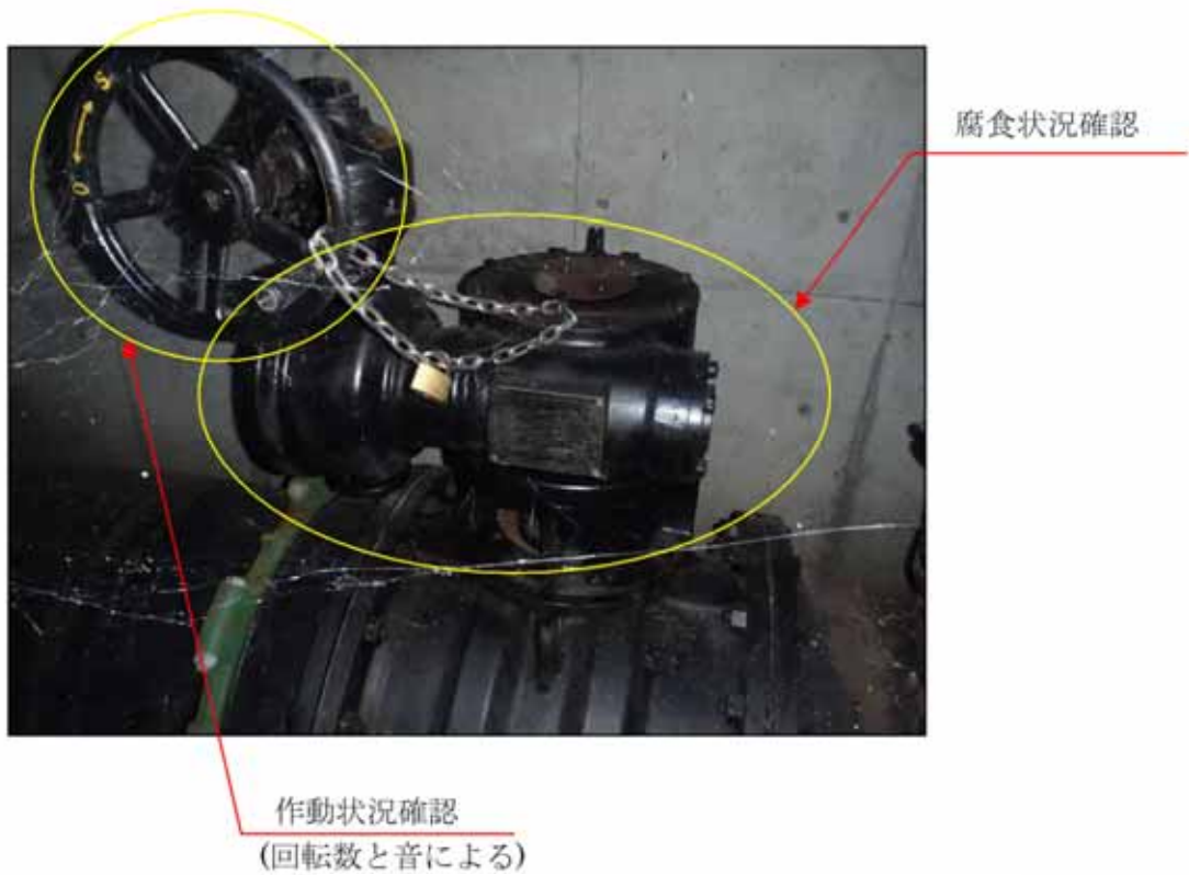
図-3.2.50 バルブ調査の内容（制水弁）
