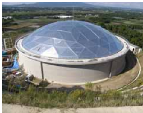
写真-3.2.79 アルミ屋根の例
