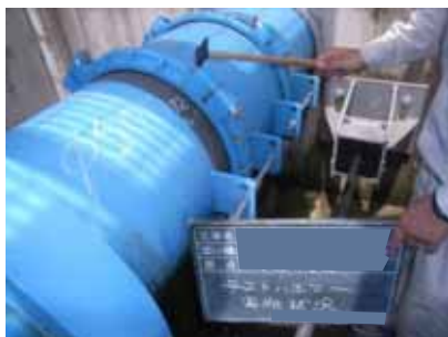
写真-3. 2. 38 テストハンマーによる調査状況
