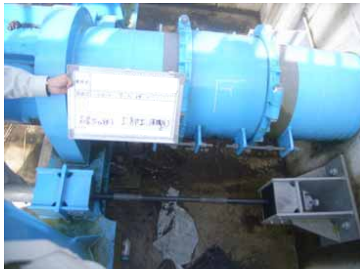
写真-3.2.47 落橋防止装置の診断状況
