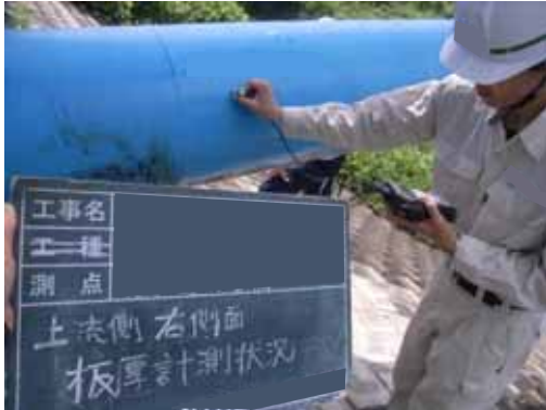
写真-3. 2. 36 測定状況
