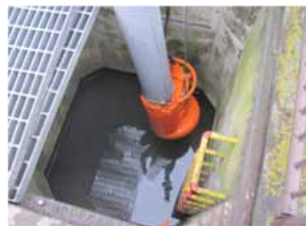
写真-3.2.5 ポンプ排水（水替え工）
