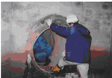
写真-3. 2. 17 分水工から管内進入
