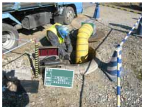
写真-3.2.6 換気状況
