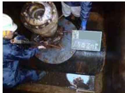
写真-3.2.4 進入部の確認
