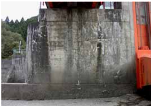
写真-3. 2. 54 凍害とASRの複合劣化 （近接すると凍害によるスケーリング・剥離が観察される）
