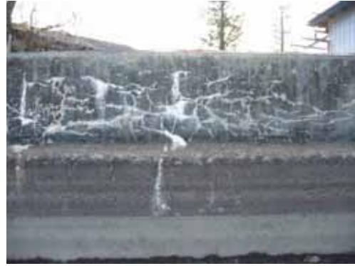
写真-3.2.68 凍害によるひび割れ（開水路の例）
