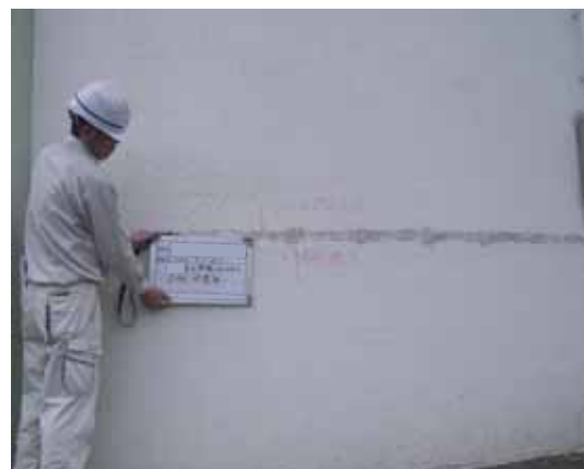
写真-3.2.70 防水塗装の上からコールドジョイントを補修している例
