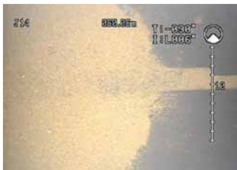
写真-3. 2. 86 管内状況（FRPM、左：継手部堆砂、右：クラック）
