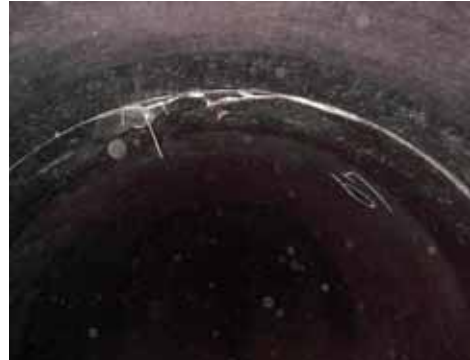
写真-3. 2. 29 継手部劣化（継手ラバーガasketの離脱）
