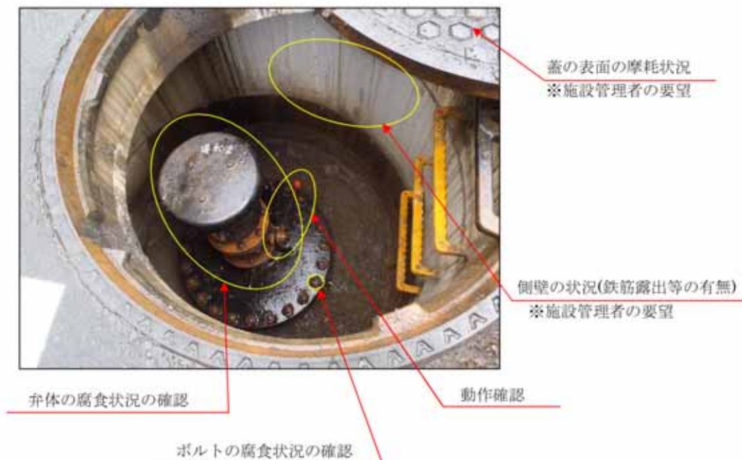
図-3.2.48 バルブ調査の内容（空気弁）
