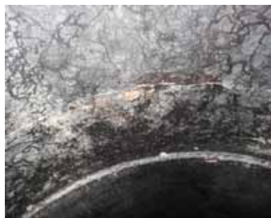
写真-3.2.87 管内発錆状況（SP）
