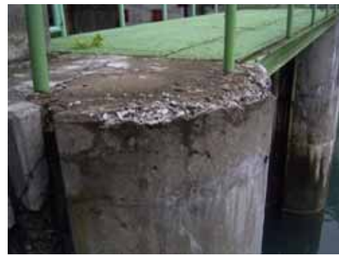
写真-3. 2. 54 凍害とASRの複合劣化 （近接すると凍害によるスケーリング・剥離が観察される）
