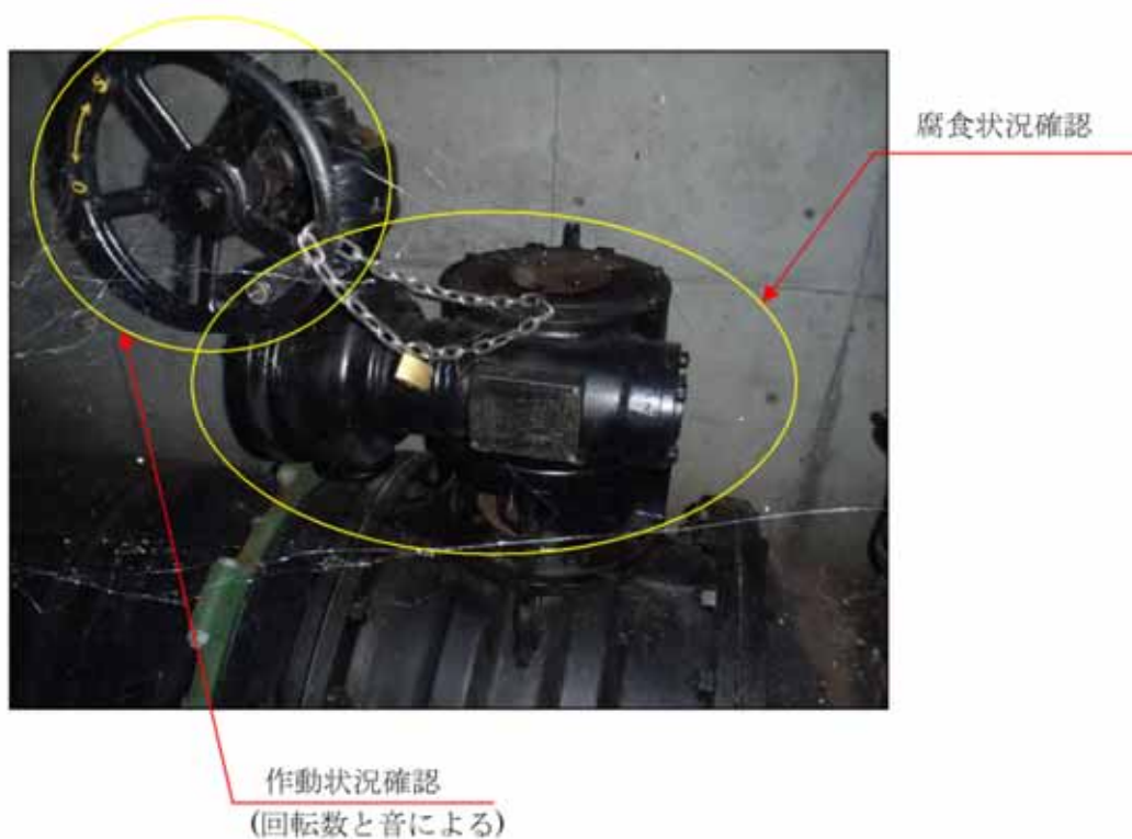
図-3.2.47 バルブ調査の内容（バタフライ弁）
