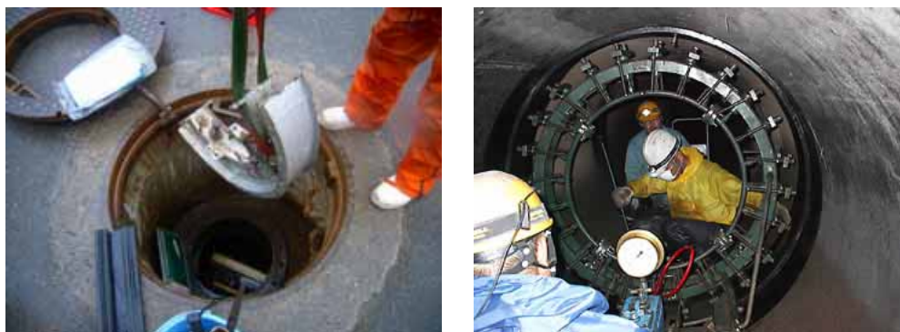
写真-3.2.30 テストバンドのセット状況
