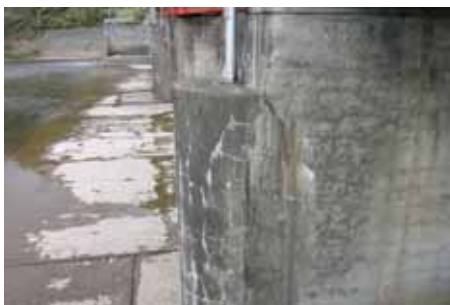
写真-3. 2. 53 ASR（ゲルの滲出が見られる）
