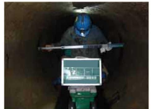
写真-3.2.25 調査状況
