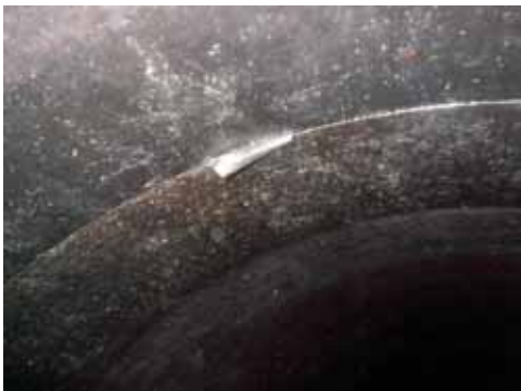
写真-3. 2. 29 継手部劣化（継手ラバーガasketの離脱）
