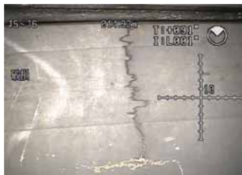
写真-3. 2. 86 管内状況（FRPM、左：継手部堆砂、右：クラック）
