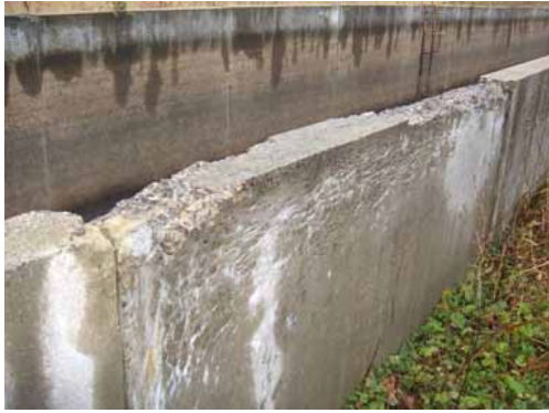
写真-3.2.68 凍害によるひび割れ（開水路の例）
