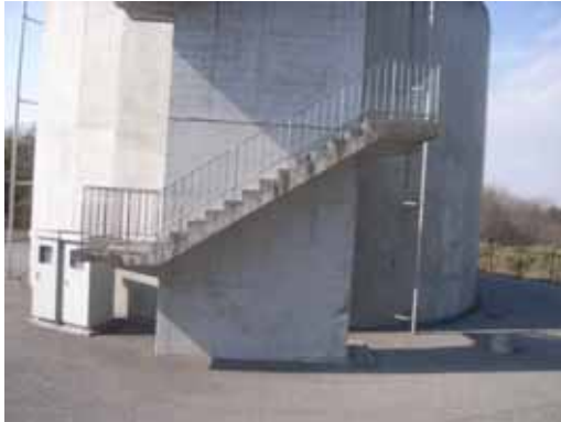
写真-3.2.81 昇降施設（ＲＣ構造）
