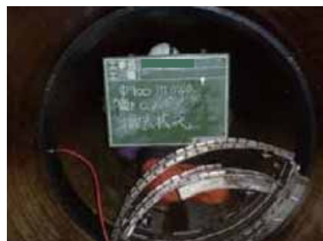
写真-3.2.31 エアー式テストバンドの搬入状況
