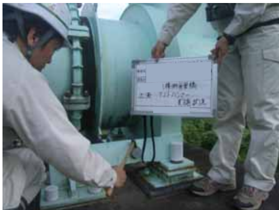
写真-3.2.43 支承部の診断状況
