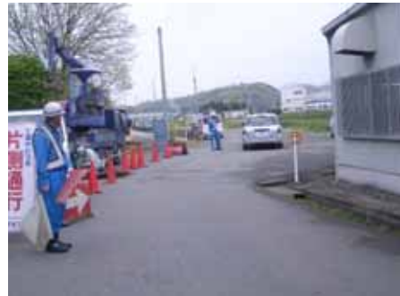
写真-3.2.3 安全施設・交通誘導員の配置
