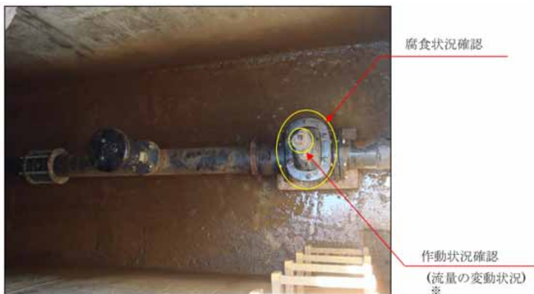
図-3.2.49 バルブ調査の内容（仕切弁）
