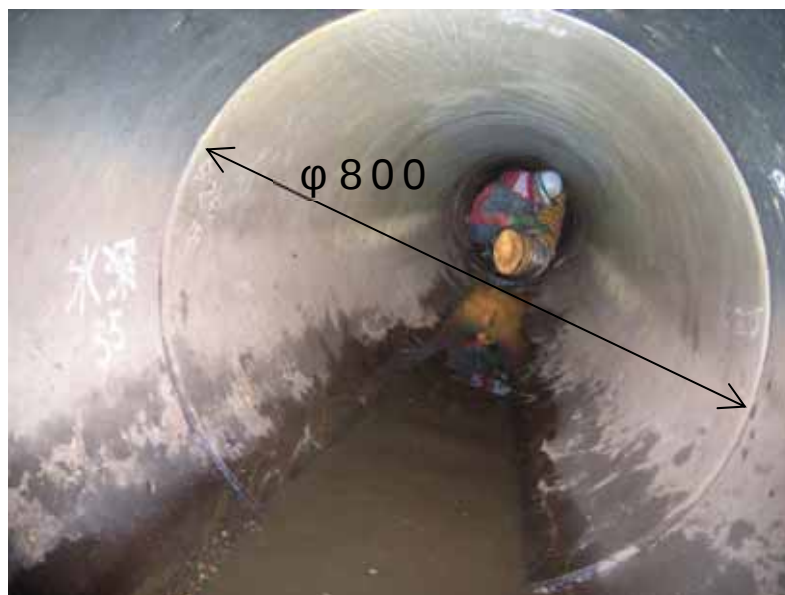
写真-3. 2. 12 φ800mm の管内での作業状況
