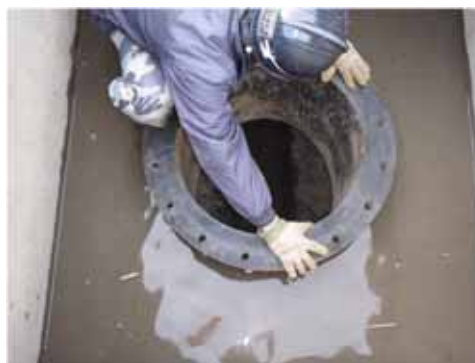
写真-3.2.9 パッキンの交換状況
