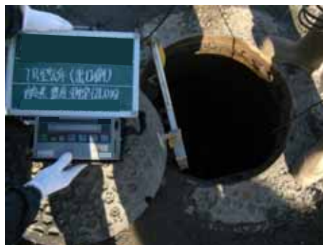
写真-3.2.7 安全確認状況
