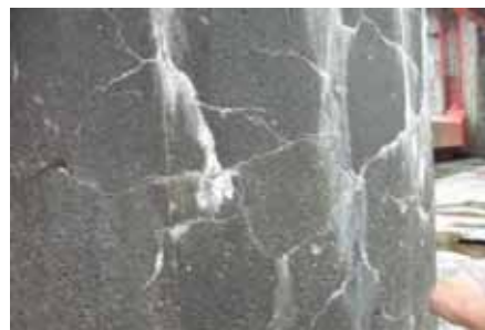
写真-3. 2. 53 ASR（ゲルの滲出が見られる）
