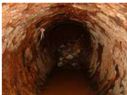
写真-3.2.87 管内発錆状況（SP）
