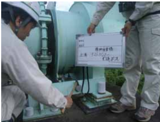
写真-3. 2. 45 伸縮継手部の診断状況
