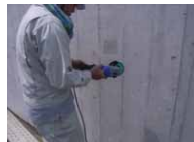
写真-3. 2. 76 表面処理の状況
