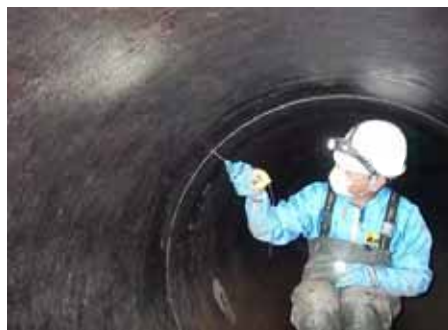
写真-3. 2. 18 管内目視調査
