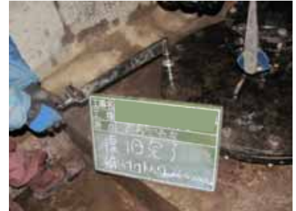
写真-3.2.10 トルクレンチによる 追い締め付け状況
