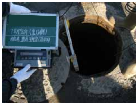
写真-3. 2. 16 ガス検知器による事前確認
