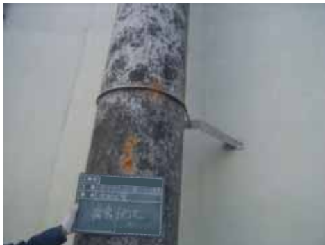
写真-3.2.85 余水吐管
