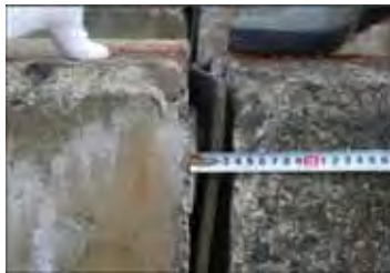
写真 硬化した目地材
