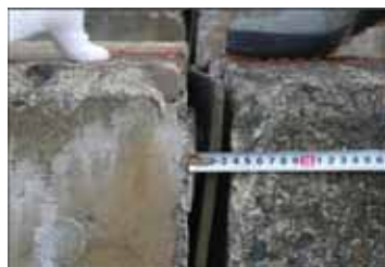
写真 硬化した目地材
