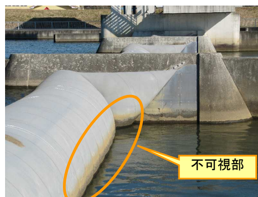
写真-7.2.3 ゴム堰端部の状況
