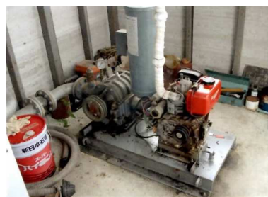
写真-7.2.12 ブロワーの性能低下
