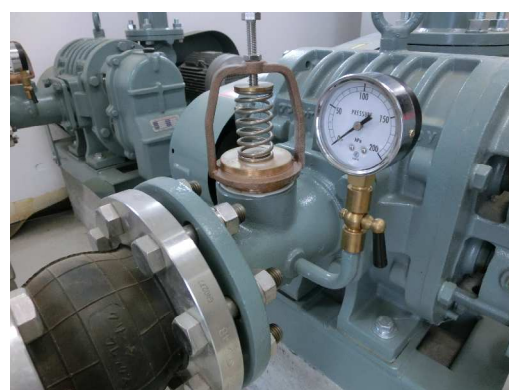
写真-7.2.5 圧力計の状況確認
