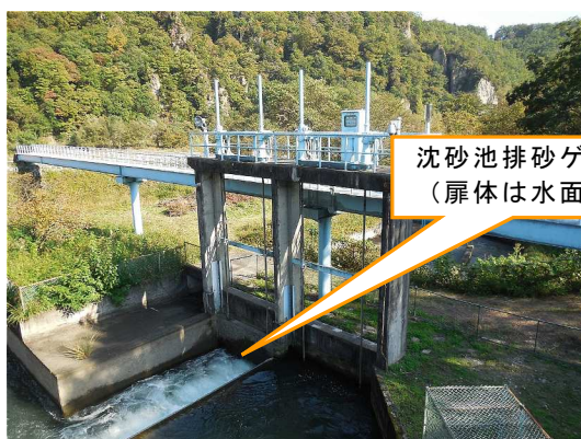
写真-7.1.4 沈砂池の排砂ゲートの設置
