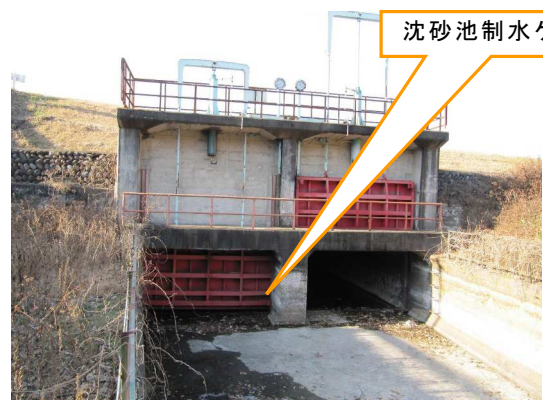
写真-7.1.3 沈砂池の制水ゲートの設置例
