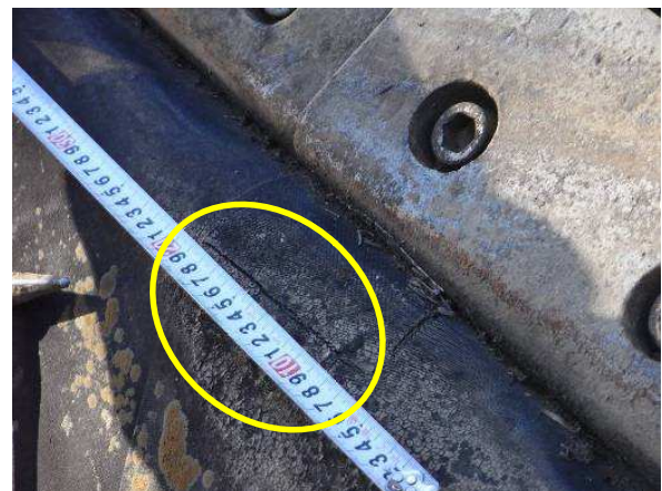
写真-7.1.9 袋体のクラックの例
