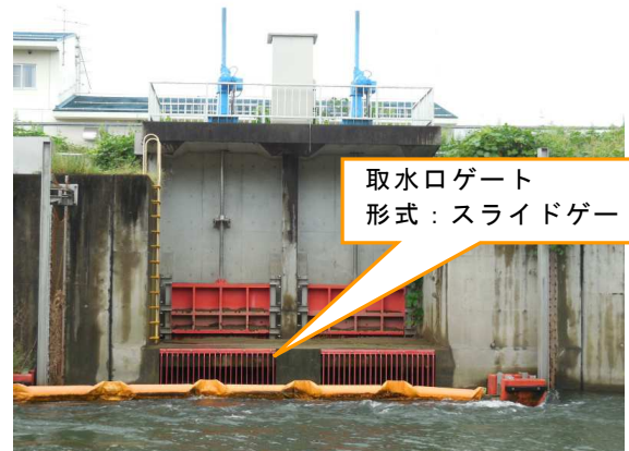
写真-7.1.2 頭首工の取水口ゲートの設置例
