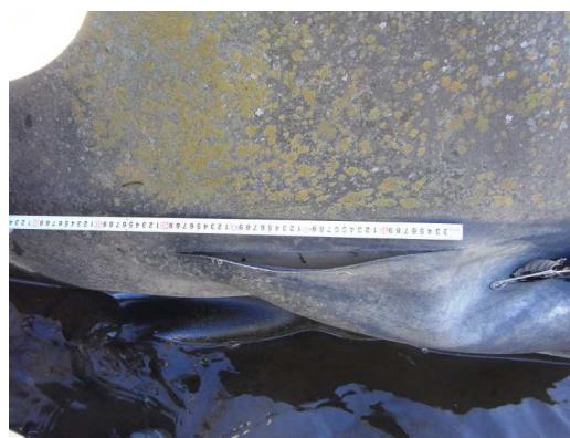
写真-7.2.6 明らかな異常（袋体の損傷）
