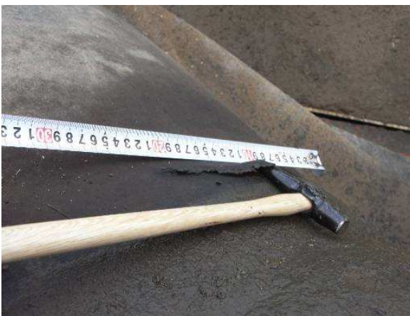
写真-7.1.8 袋体の損傷の例
