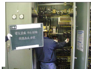
絶縁抵抗測定状況
