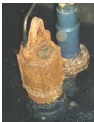
写真-7.2.13 水中ポンプの劣化
