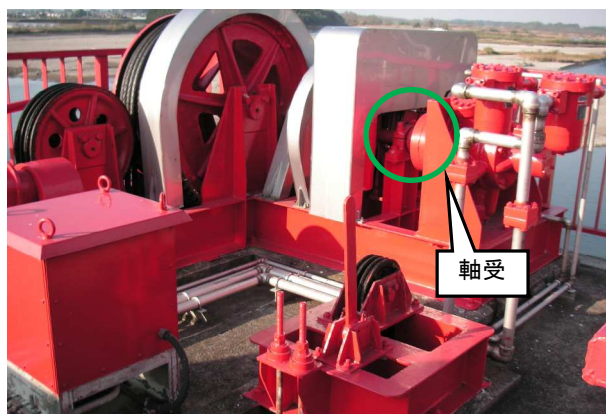
③開閉装置の軸受の摩耗量確認等
