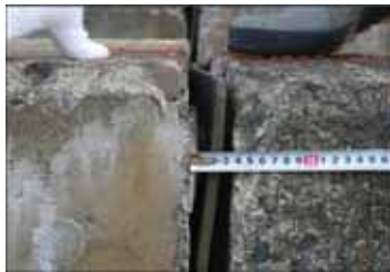
写真 硬化した目地材
