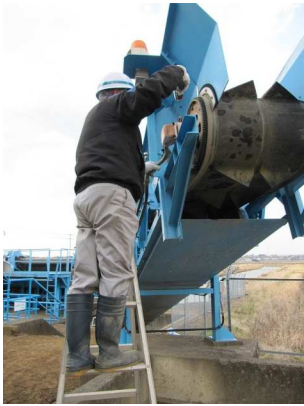
写真-9.2.7 コンベヤ点検状況
