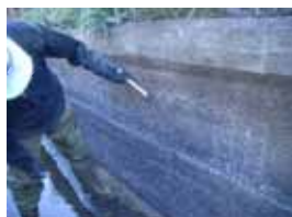
テストハンマーによる 打音調査
