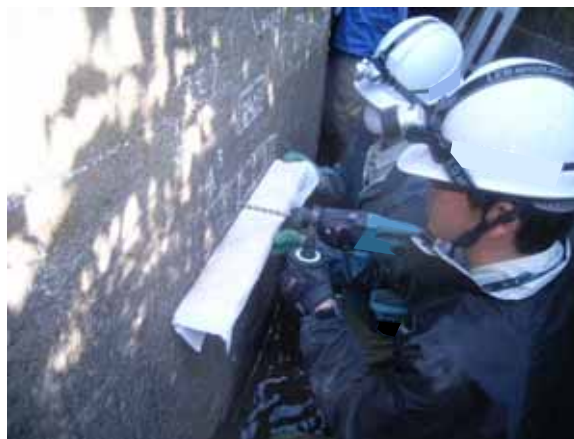
写真-1.2.19 ドリル法による中性化試験
