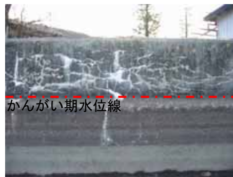
写真-1.2.12 凍害によるひび割れ
