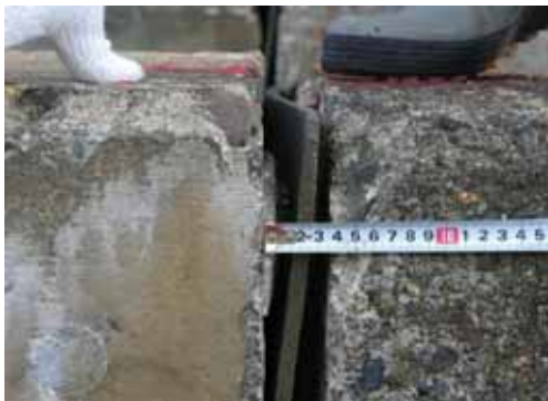
写真-1.2.23 硬化した目地材
