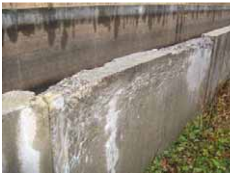
写真-1.2.12 凍害によるひび割れ
