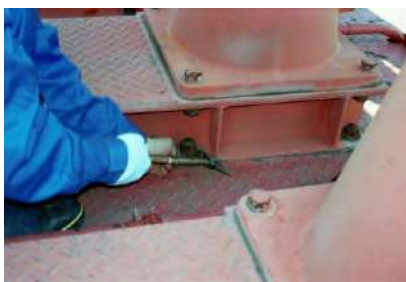
写真 5.2.5 テストハンマーによる打診確認
