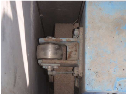
サイドルーラ（扉体）の動作確認
