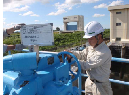
手動ハンドル（開閉装置）の動作確認
