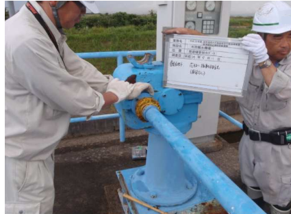
開閉装置（軸継手）の振動・加熱確認
