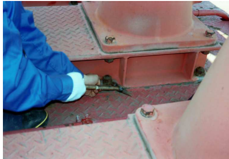
テストハンマーによる打診確認
