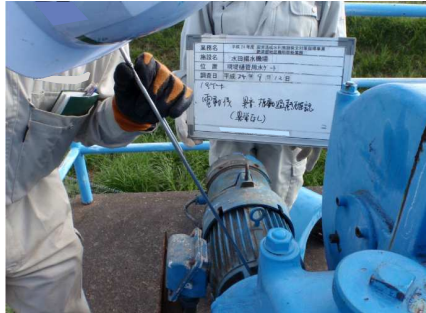
開閉装置（電動機）の異常音確認
