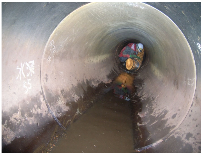
【写真 4-14 口径 800mm の管路での現地調査状況】
