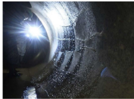
【写真 4 - 3 （PC/RC 管 管体破損）】
