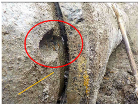
【写真 4 - 2 PC/RC 管（継手ゴム劣化・腐食）】
