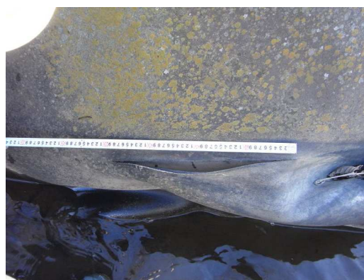
写真-7.2.6 明らかな異常（袋体の損傷）
