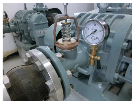
写真-7.2.5 圧力計の状況確認
