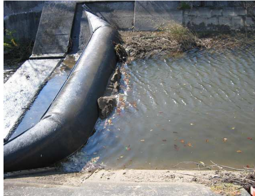
写真-7.2.7 堆砂、塵芥状況確認
