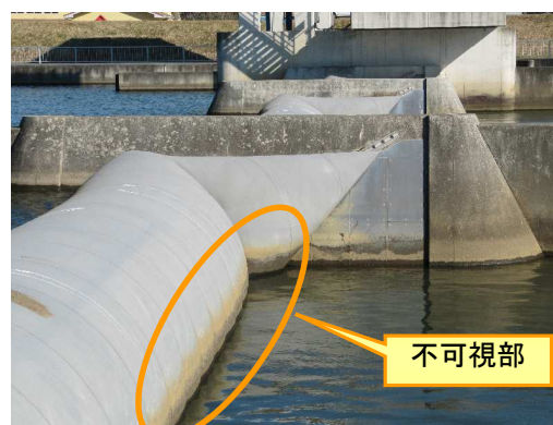
写真-7.2.3 ゴム堰端部の状況
