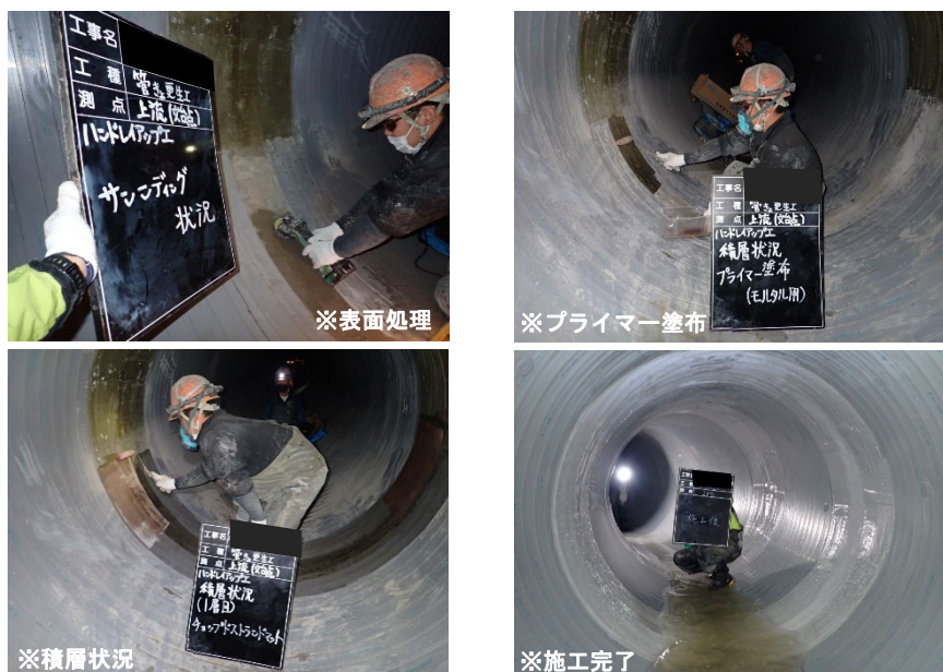
図 49 ハンドレイアップの施工事例
