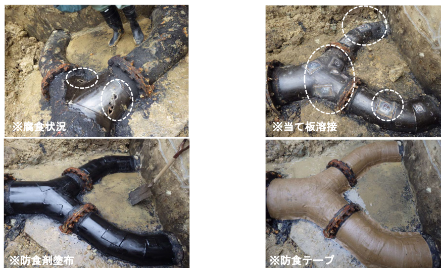
図 48 当て板工法による補修事例
