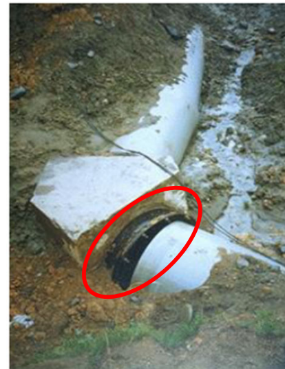
【写真3-1 曲管周辺での継手の離脱】 【写真3-2 液状化に伴う構造物の浮上】
