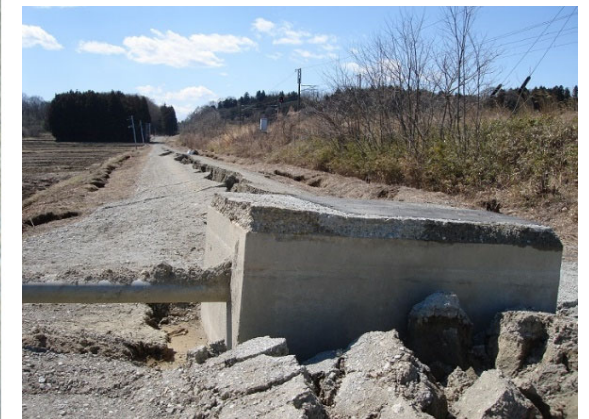
【写真3-1 曲管周辺での継手の離脱】 【写真3-2 液状化に伴う構造物の浮上】
