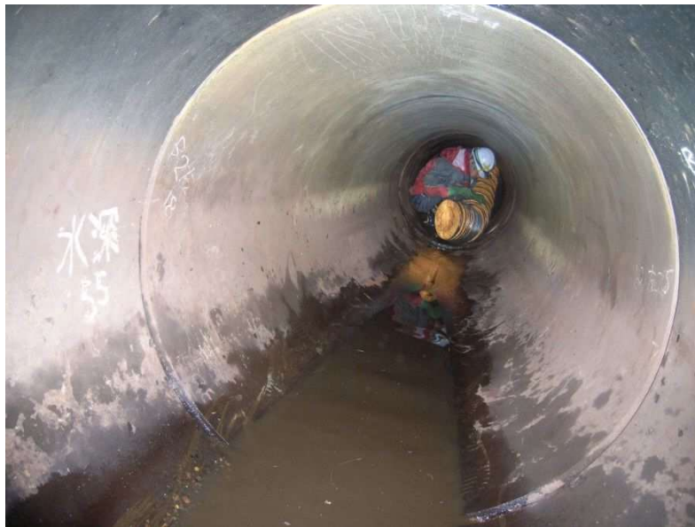
【写真 4-14 口径 800mm の管路での現地調査状況】
