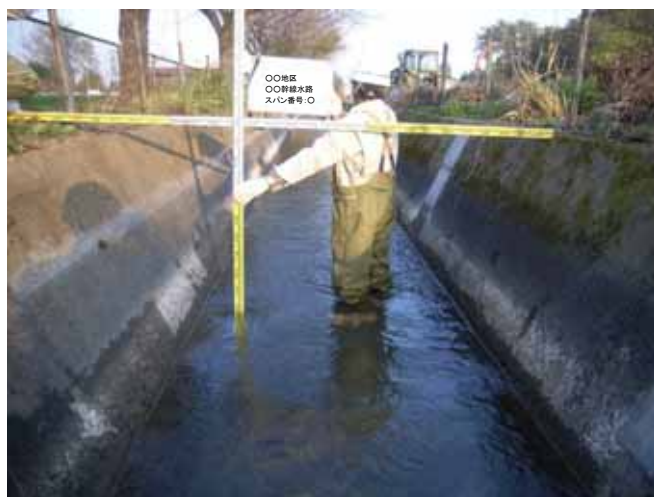
写真-1.2.3 水路全景
