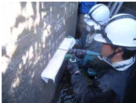
写真-1.2.19 ドリル法による中性化試験
