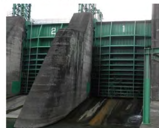
写真-1.2 堤体下流面
