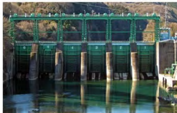
写真-1.1 堤体上流面
