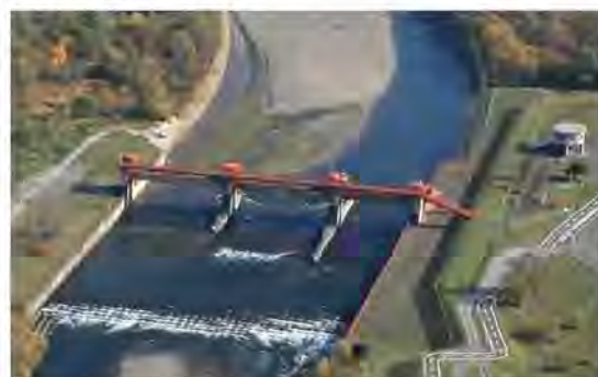
写真-1 大雪頭首工全景
