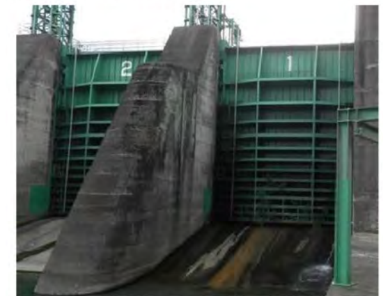
写真-1.2 堤体下流面
