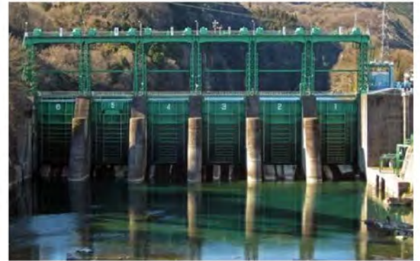
写真-1.1 堤体上流面
